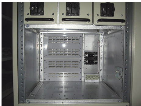
\\ Подключение стандартного выдвигного блока \\
